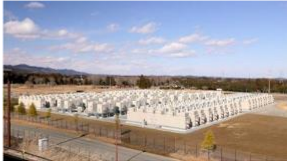
Hình 84: Hệ thống lưu trữ năng lượng 40 MW và 40 MWh tại Fukushima, Nhật Bản (Tài liệu tham khảo 48).
