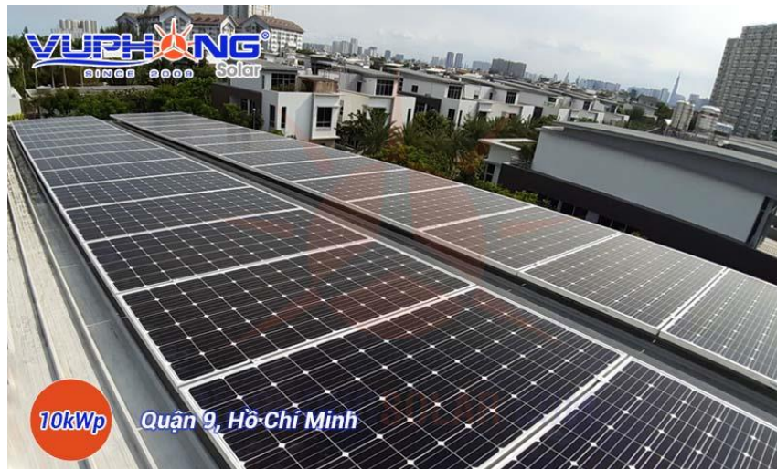
Dự án ĐMT mái nhà tại Quận 9, TP. Hồ Chí Minh (10,08 kWp)
