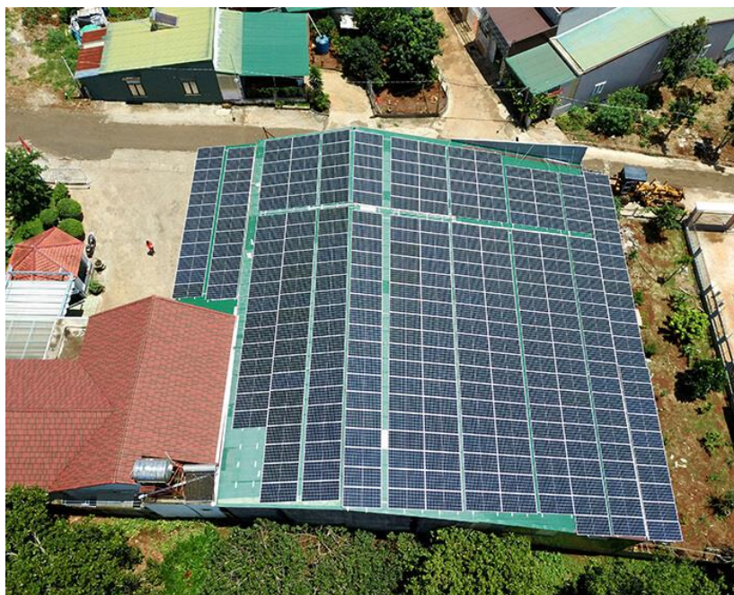
Dự án ĐMT mái nhà tại tỉnh Đắk Nông (135 kWp)
